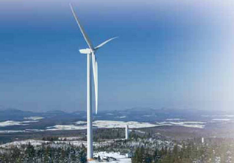
Ce projet génèrera de l'énergie permettant d'alimenter en électricité l'équivalent de plus de 18 000 foyers québécois.
