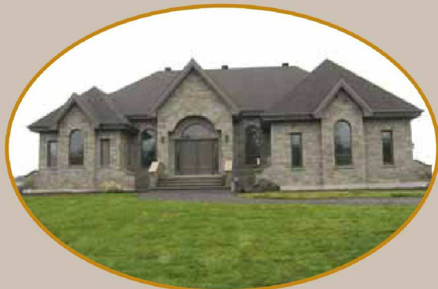
Gaétan Berger entreprend la construction de deux à trois maisons par année.
