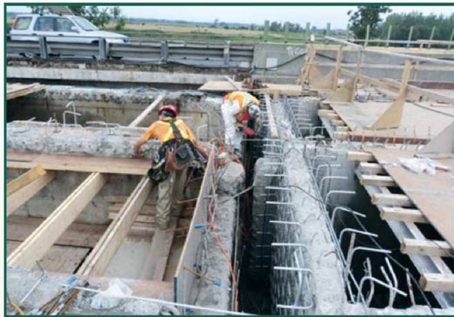
*Ce projet visait à démolir le tablier du pont Sud, à installer de nouveaux appareils d'appui, à reconstruire les diaphragmes et à refaire les dalles avec de nouveaux parapets.*
