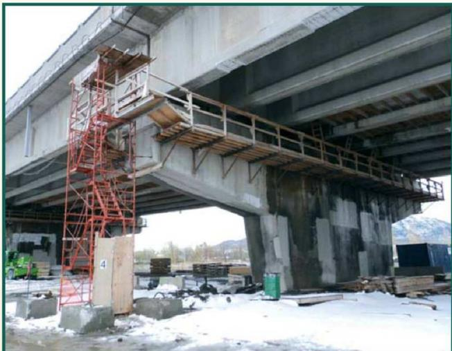
On a dû soulever le pont pour changer les appareils d'appui.
