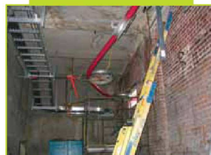
Câbles avec poulies pour l'installation des câbles de moyenne puissance à un poste de pompage.
