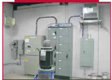
Aujourd'hui, l'entreprise emploie une cinquantaine de personnes et répond aux besoins d'autant de clients dans les secteurs industriel, municipal et du génie civil.
