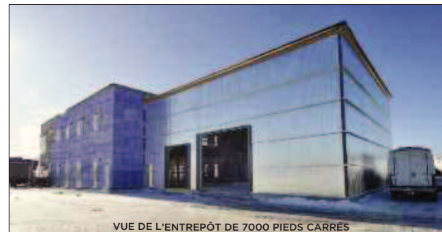
VUE DE L'ENTREPÔT DE 7000 PIEDS CARRÉS
