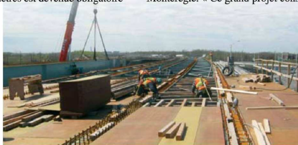
Mise en place des formes pour la construction de la dalle du pont d'étagement de l'autoroute 30 en direction est, qui passe au-dessus de la route 930.
